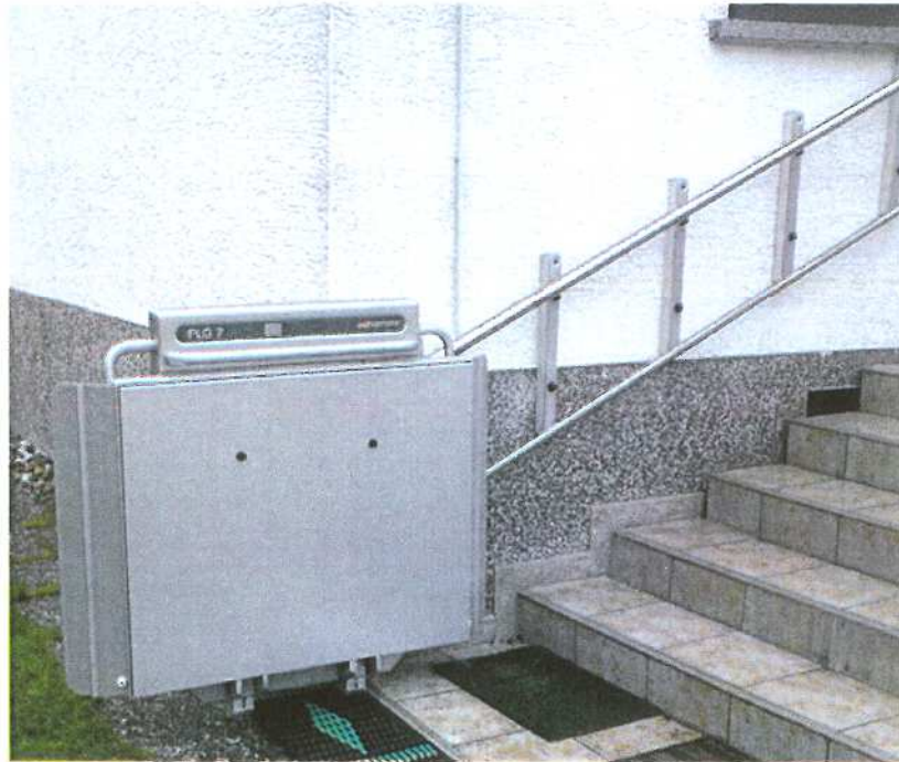
Fot. 1 - Widok platformy - po złożeniu
